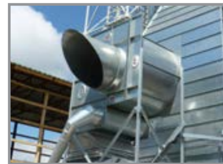
Центробежный пылеотделитель на выходе агента сушки
