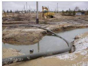
В горнодобывающей и горноперерабатывающей отрасли легко монтируемый и демонтируемый трубопровод свободно используется в труднодоступных местах: грунтопровод, водогрутопровод, золоудаление, шлакоудаление, пульпопровод, перекачка бурого шлама, глины, песка, гравия и тд.
