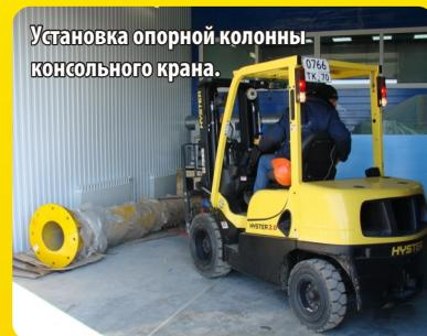
Установка опорной колонны консольного крана.
