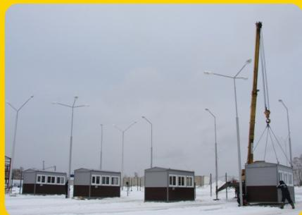
Модульное здание котельной 7,25х5,25х4,05м
