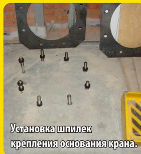
Установка шпилек крепления основания крана.
