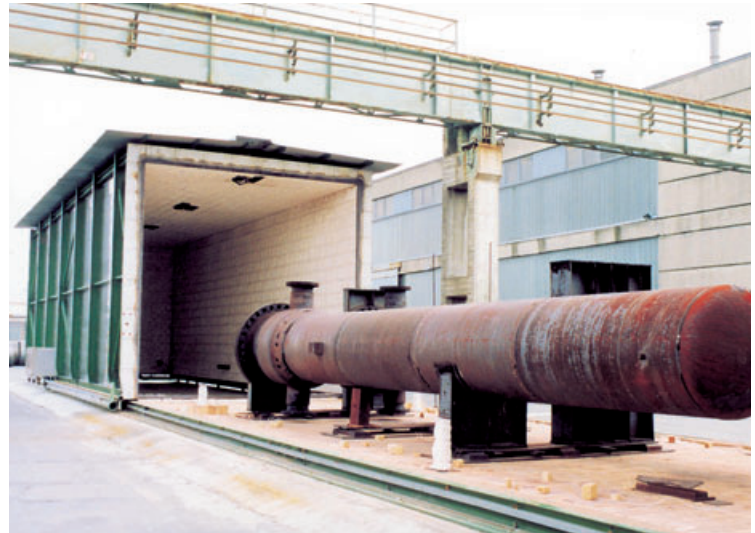
Печь с газовым обогревом для отжига большегрузных контейнеров.
